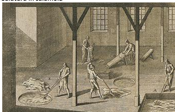
Figura 6.5 La salatura delle pelli può essere effettuata a secco (a sin.; Foto @N. Perini) o in salamoia (a dest.; J.H.G. von Justi, Die Kunst Pergament zu machen, Berlino, 1763; da: Fuchs, 2018)
